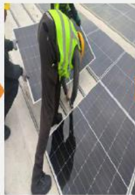
2. 2人抬组件两侧，1人连接相邻组件的电缆线接头，听到“咯嗒”为连接成功。
