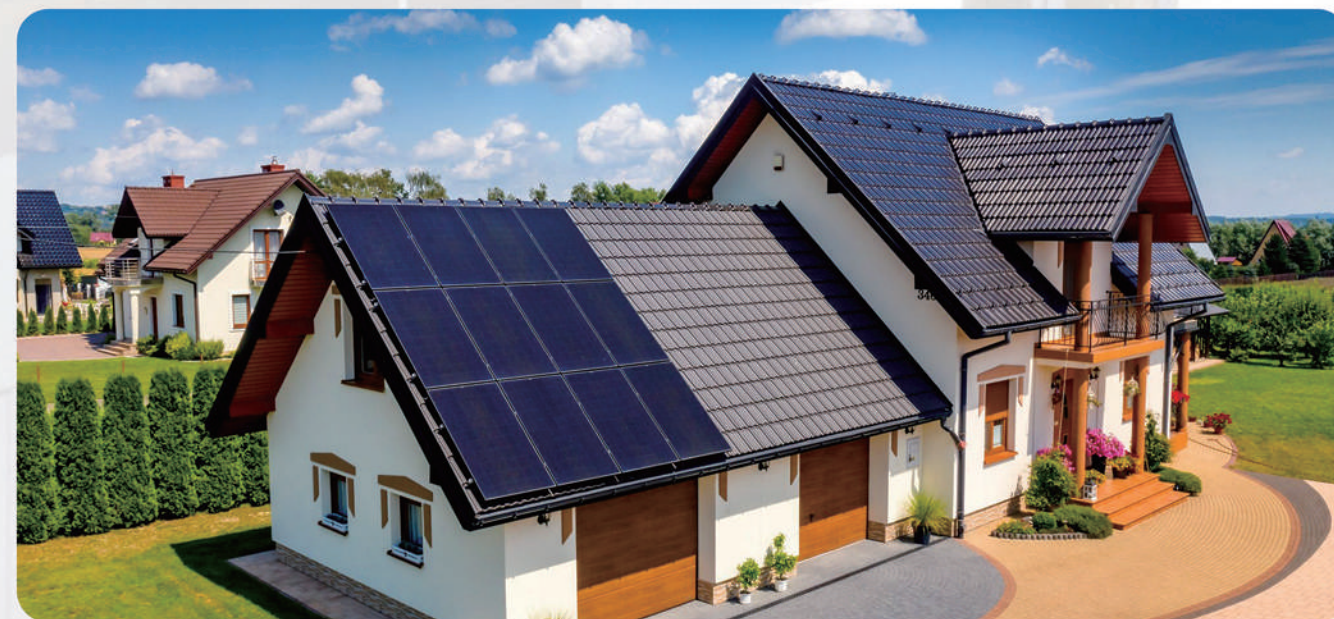
项目地点：波兰 项目规模：4.2 kW
