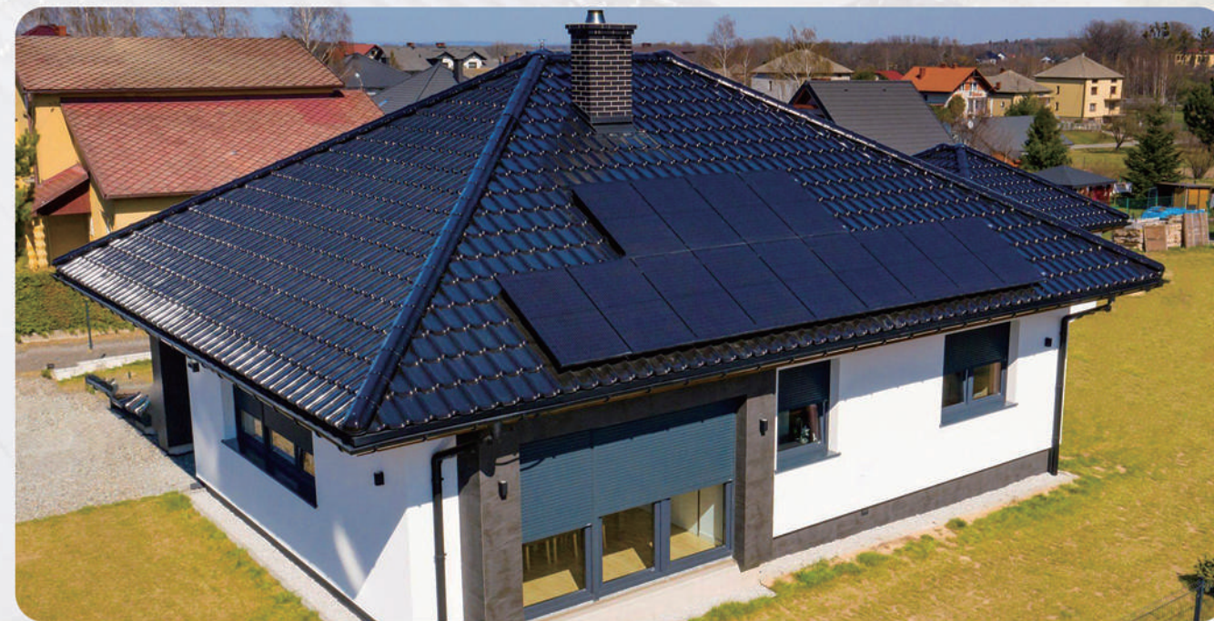
项目地点：波兰 项目规模：4.6 kW
