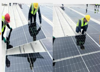
3. 抬组件的两人顺势把组件放到安装位置。相邻组件留好间距 \geq 30\text{mm}
